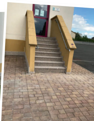
Réfection des bordures Salle des fêtes « René Martini »
