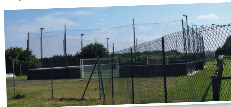
Pump track – Espace vert • Terrain de Foot – Clôture
